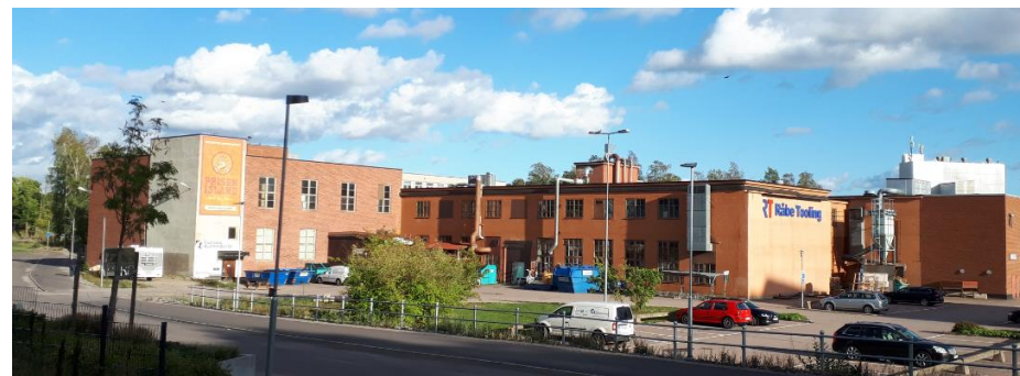
Befintlig bebyggelse på fastigheten
