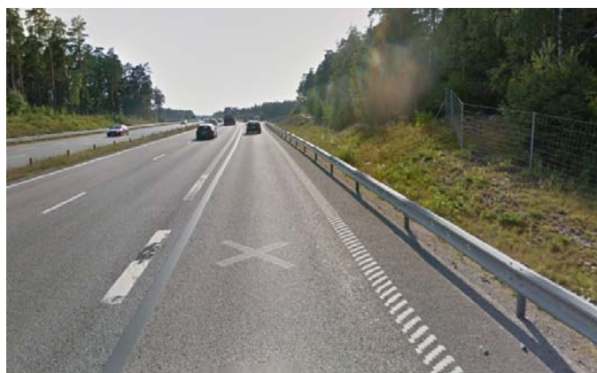
Figur 4. Bild tagen öster om västerledsmotet i riktning västerut längs transportleden (E18). Detaljplaneområdet är till höger i bilden.
