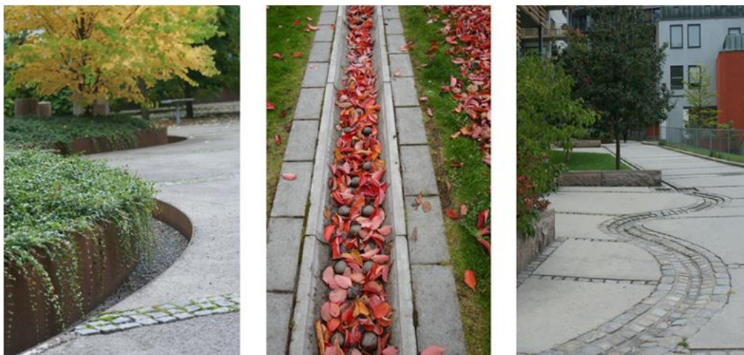
Figur 24. Exempel på utformning av dagvattenrännor i urban miljö (Foto: Sweco).
