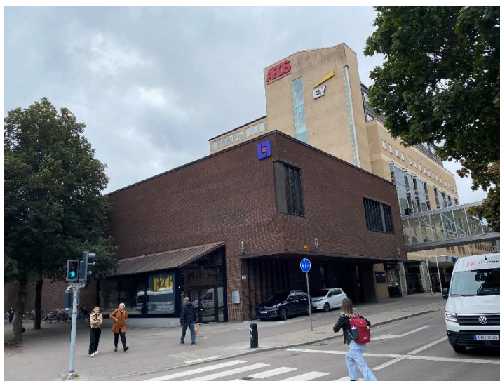
Korsningen Kopparlundsgatan/ Munkgatan.
