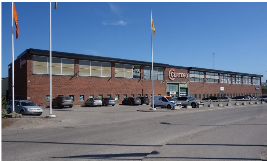
Norr om Pressverksgatan står Svenska Metallverkens tidigare lager- och speditjonsbyggnad som byggts om och till vid ett flertal tillfällen. Den kommer att rivas enligt förslaget.
