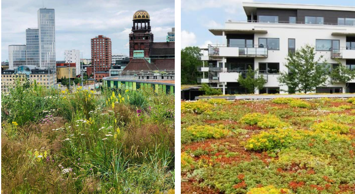
Figur 4. Biotoptak (till vänster) och ett moss-sedumtak (till höger). Bilder från Vegtech, hämtade 2024-02-26.
