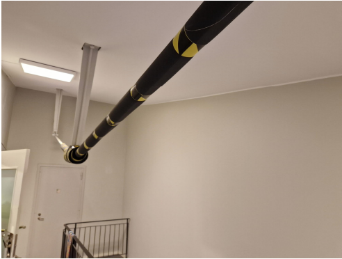
Figur 3. Svart cellgummiisolering som innehåller bromerade flamskyddsmedel.
