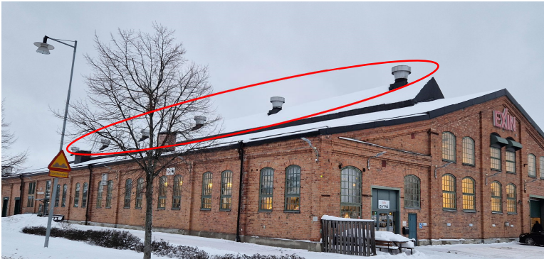
Figur 2. Pannorna på byggnadens tak kan innehålla eternit (asbestcement) på insidan.
