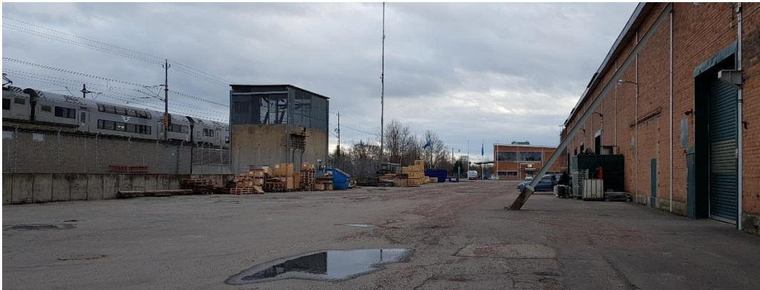
Figur 16. Pressverksgatan i planområdets nordöstra del har svag social kontroll i och med att fasaden saknar fönster. Mälarenergis teknikhus och taggtrådsförsedda stängsel skapar ett ogästvänligt intryck.
