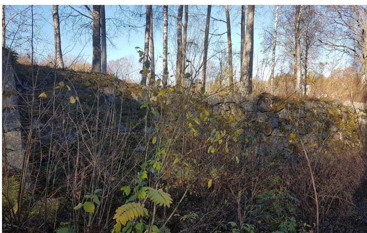
Bild 7.3.1: Befintlig mur i sektion C.
