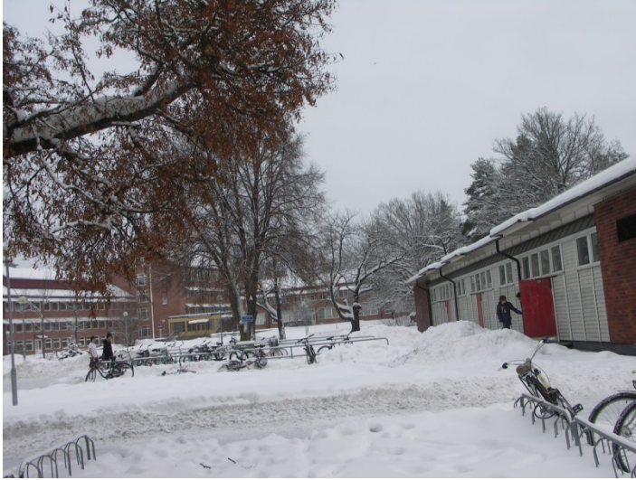
Gymnastikhallen som ska rivas
