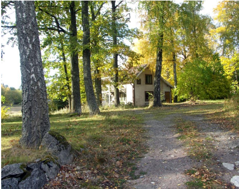
Byggnad värdefull för området, utpekat av Västerås stad i samband med detaljplanarbetet.
