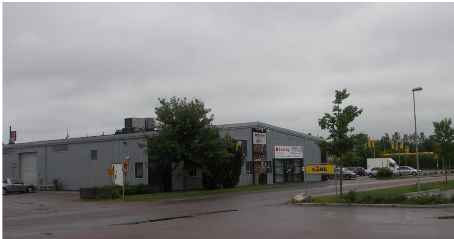
Befintlig byggnad inom fastigheten Hjulsmeden 4.
