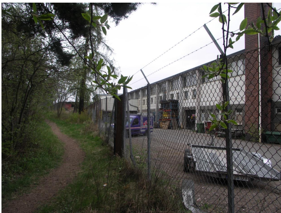
Nuvarande byggnad sedd från söder
