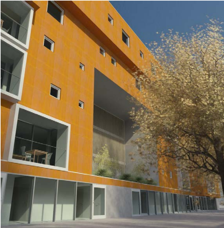
Genomsiktliga ytor i fasaden skänker ljus till parkeringshuset
