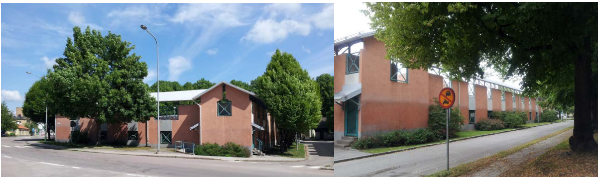
Parkeringshuset i kvarteret Högne som ska byggas kring och på
