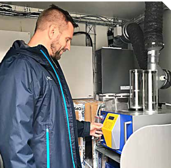
Fredrik Ahlin i luftmätningstationen vid Melkertorget.
