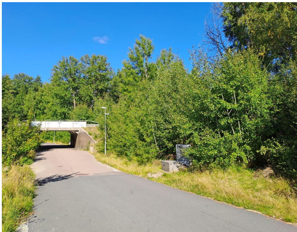
9 Det ansamlas dagvatten nära gc-tunneln vid regn. Pumphälsningen syns öster om gc-vägen.
