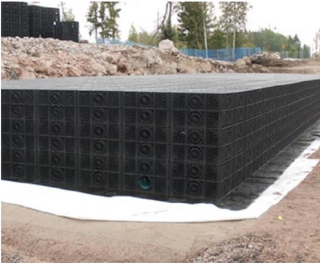
Figur 17. Exempel på hur ett kassetmagasin kan utformas. (Bild från Uponor).
