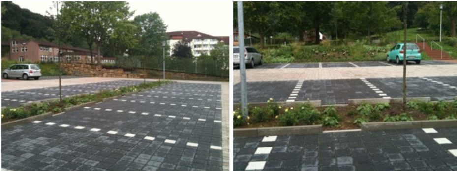
Figur 15. Exempel på växtbäddar vid parkeringsplatser. Här är växtbäddarna anlagda med god möjlighet för dagvatten att rinna in i anläggningen. Foto: Sweco.
