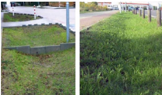
Figur 14. Exempel på hur gräsbeklädda diken kan utformas. Bilderna kommer från Stockholm Vatten och Avfall.
