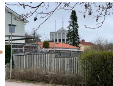
VATTENTORNET Vattentornet har i huvudsak en ljus grå nyans med släta pelare. Volymen bryts av med ett pelarsystem. Den rosa kulören på översta våningen präglar dock starkt intrycket på avstånd.
