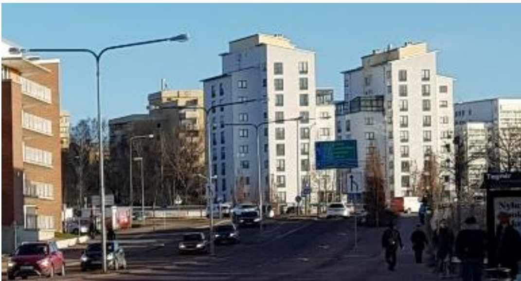
Figur 14. Rondellen vid Emmausmotet skulle utgöra en del av barnens skolväg utifall gångbron över E18 inte skulle byggas. Foto taget från söder på Kopparbergsvägen. Foto: Tyréns.
